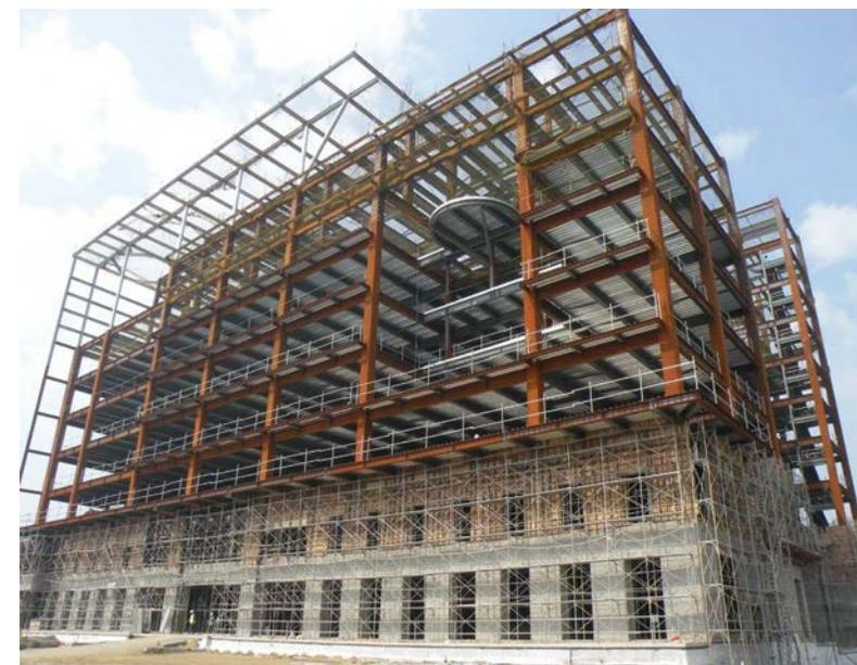
上圖為地上樓層鋼柱及鋼樑吊裝完成。
