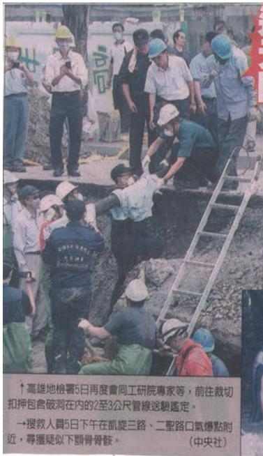
↑高雄地檢署5日再度會同工研院專家等，前往切割扣押包含破洞在內的2至3公尺管線送驗鑑定。
