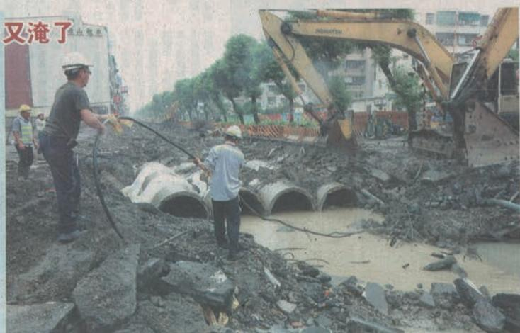
【記者徐如宜、歐陽良盛、劉星君／高雄報導】高雄氣爆第十一天, 李長榮化工廠接管線的丙烷殘留, 清完, 箱涵內暫接的PVC管是拖延進度的主因, 高市環保局決定, 今天將在箱涵兩側外接「口」字型耐壓鋼管, 加速清除餘氣。
