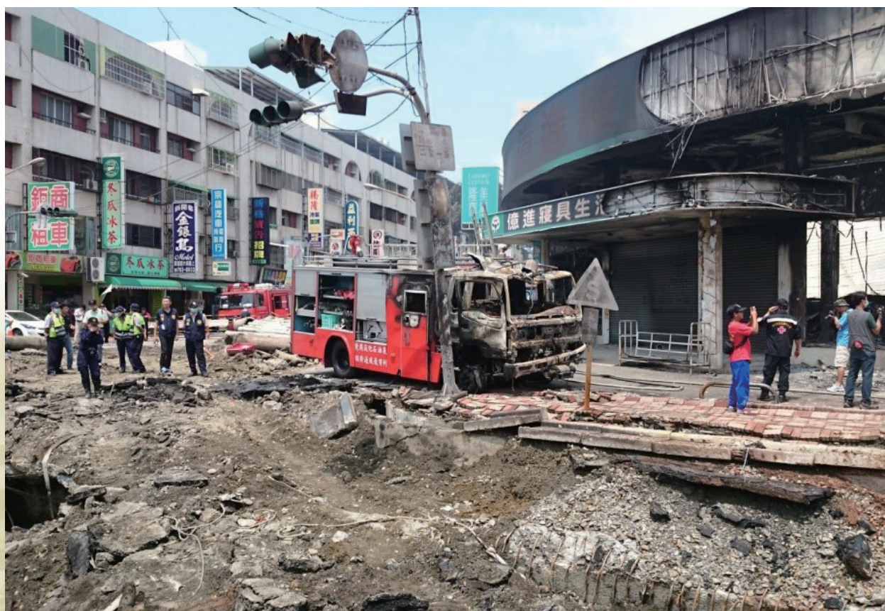
地點：高雄市二聖、凱旋路口 說明：第一氣爆點發生後現場。
