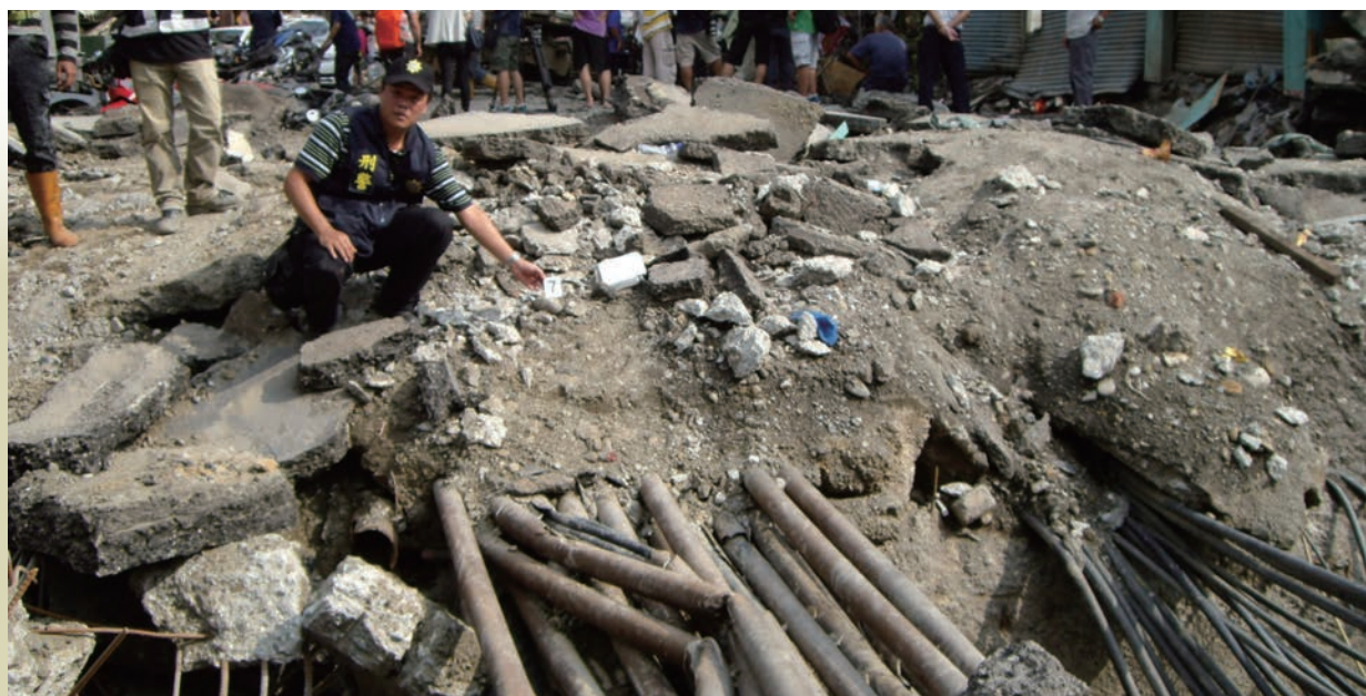
地下埋藏了許多難以分辨來源的管線
