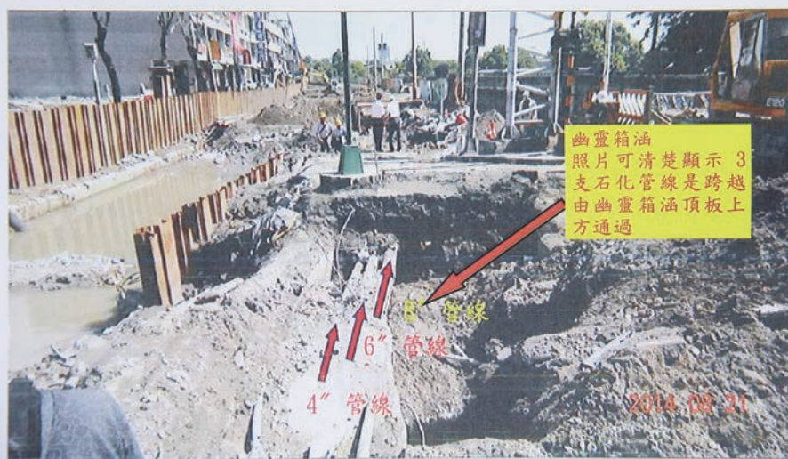
3支石化管線由上方跨越幽靈箱涵（南側箱涵）之俯視照片
