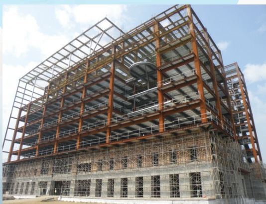
地上樓層鋼柱及鋼樑吊裝完成
