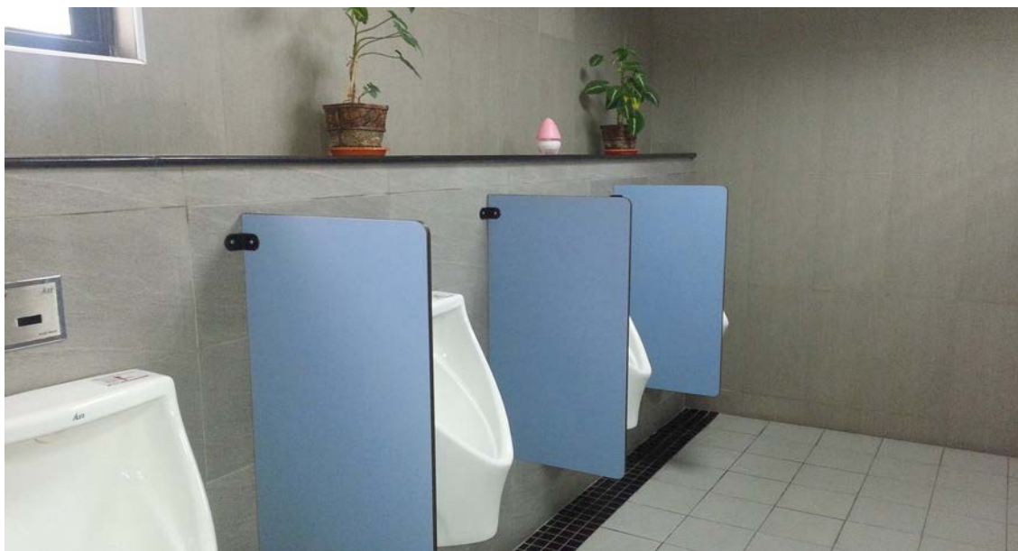
廁所整建後，非常通風、清潔、明亮
