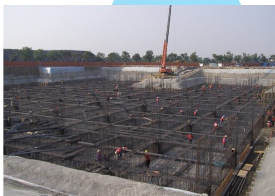
基礎結構鋼筋施工
