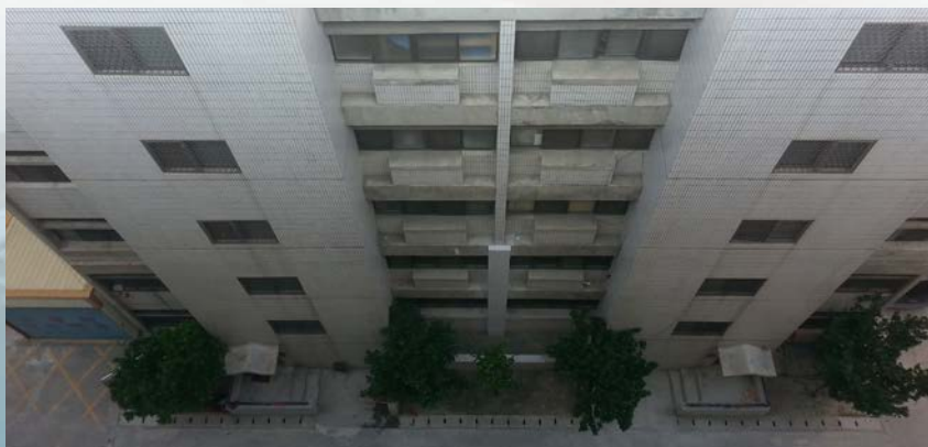
替代役宿舍完工後，3 樓以下樑柱加寬，更顯穩固
