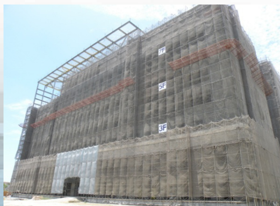
地上樓層外牆混凝土澆置完成
