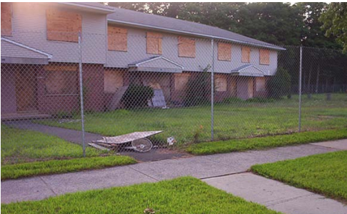
Brookside 整排廢棄住宅，窗戶被封死的情形
