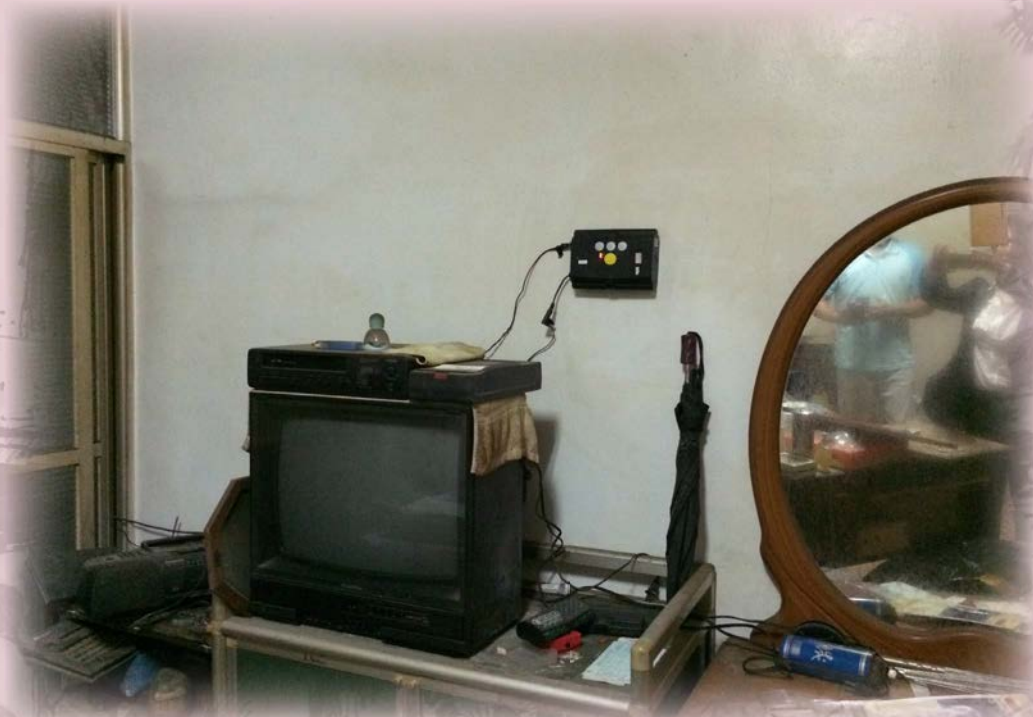
▲ 科技監控設備
